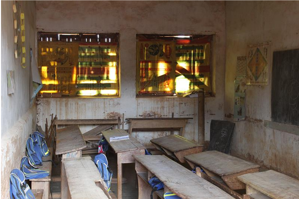
l'ancien bâtiment qui devrait être transformé en cantine
